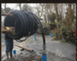
Ouverture des tranchées
