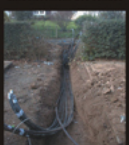
Mise en place regard collecteur
