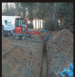
Enfouissement des sondes
