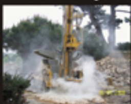
Mise en place des sondes
